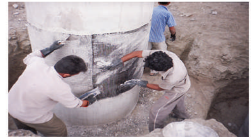
شکل ۱۰ - محصور کردن با استفاده از CFRP
