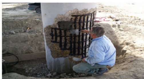
شکل ۶- جایگزینی بتن با ملات الیافی FRC دارای MCI شکل ۷- بتن قلبیایی سالم در تست فنل فتالین
