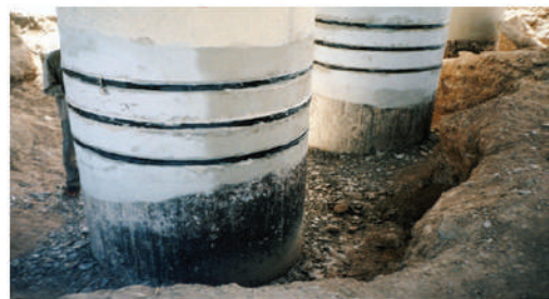
شکل ۱۱ - محصور کردن با استفاده از تسمه CFRP
