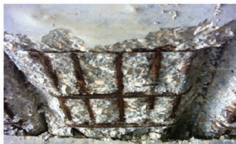
شکل ۴ - سازه تخریب شده در اثر خوردگی
