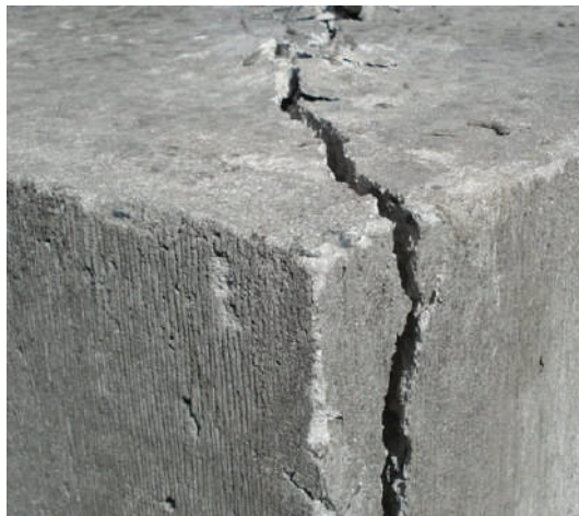
شکل ۲ ترک D شکل ناشی از انجماد و ذوب
