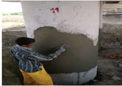
شکل ۹ - پوشش نهایی با ملات الیافی پلیمری
