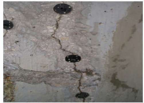
شکل ۸ - پگرها برای تزریق اپوکسی به داخل ترک ها
