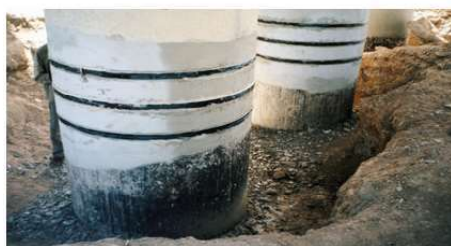
شکل ۱۰- سحصورکردن با استفاده از CFRP شکل ۱۱- سحصور کردن با استفاده از تسمه CFRP
