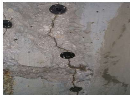
شکل ۸- پکرها برای تزریق اپوکسی به داخل ترک ها شکل ۹- پوشش نهایی با ملات الیافی پلیمری
