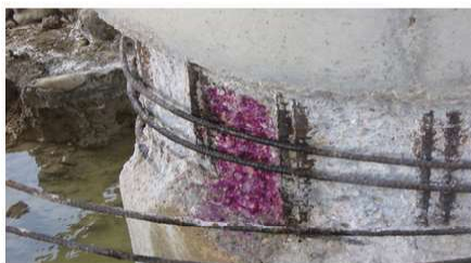
شکل ۶ - جایگزینی بتن با ملات الیافی FRC دارای MCI شکل ۷ - بتن قلیایی سالم در تست فنل فتالین
