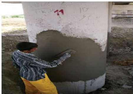
شکل ۸- پکرها برای تزریق اپوکسی به داخل ترک ها شکل ۹- پوشش نهایی با ملات الیافی پلیمری
