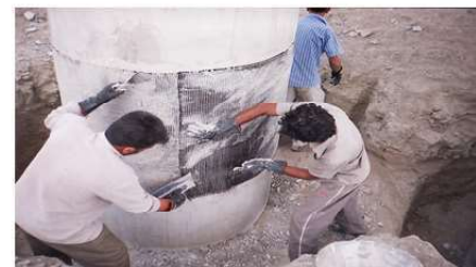
شکل ۱۰- سحصورکردن با استفاده از CFRP شکل ۱۱- سحصور کردن با استفاده از تسمه CFRP
