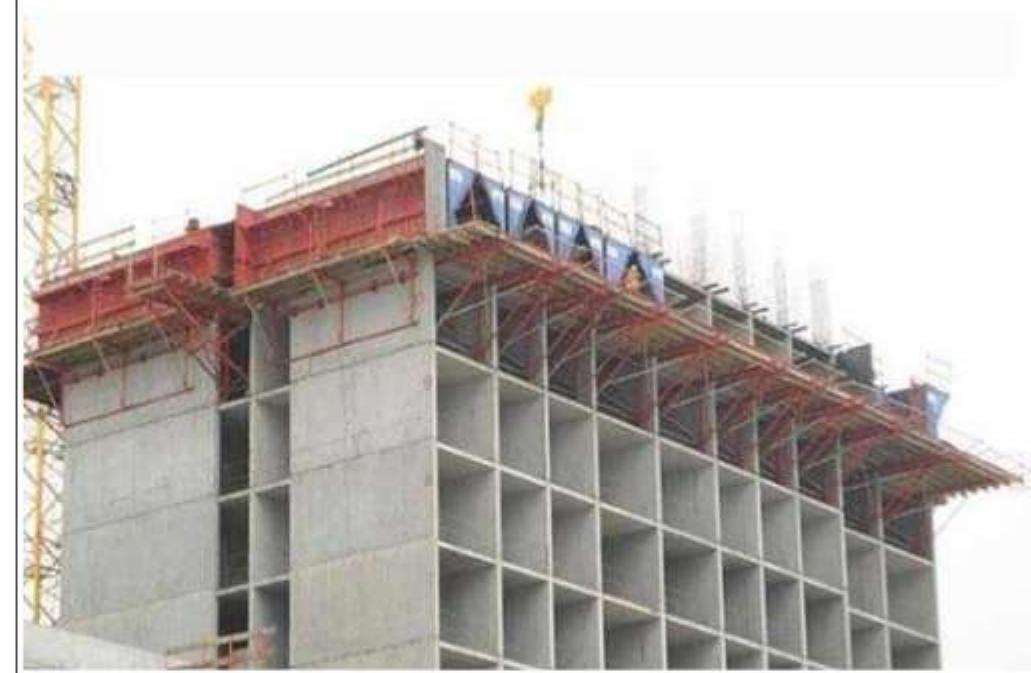
شکل 7- ساختمان‌های بتن‌آرمه درجا به شیوه قالب‌های تونلی
