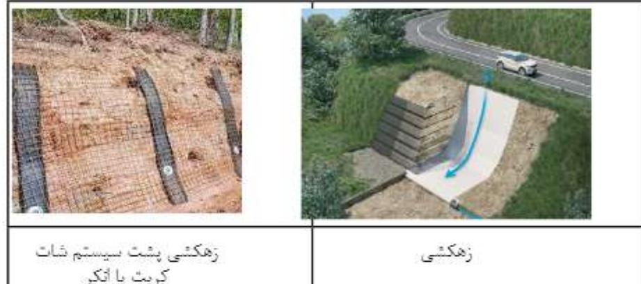
شکل ۷- کاربرد زیوستیک‌ها در فیلتر و زهکشی (23) و (24)
