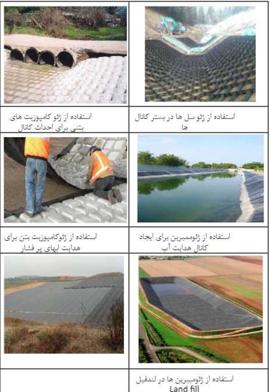
شکل ۱۲- کاربرد ژئوستیک‌ها در کانال‌ها و سازه‌های هیدرولیکی (35) و (36)
